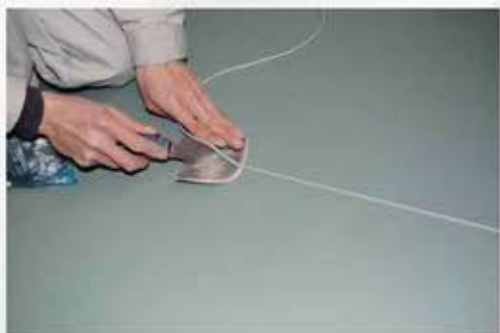
Выравнивание лопаткой
